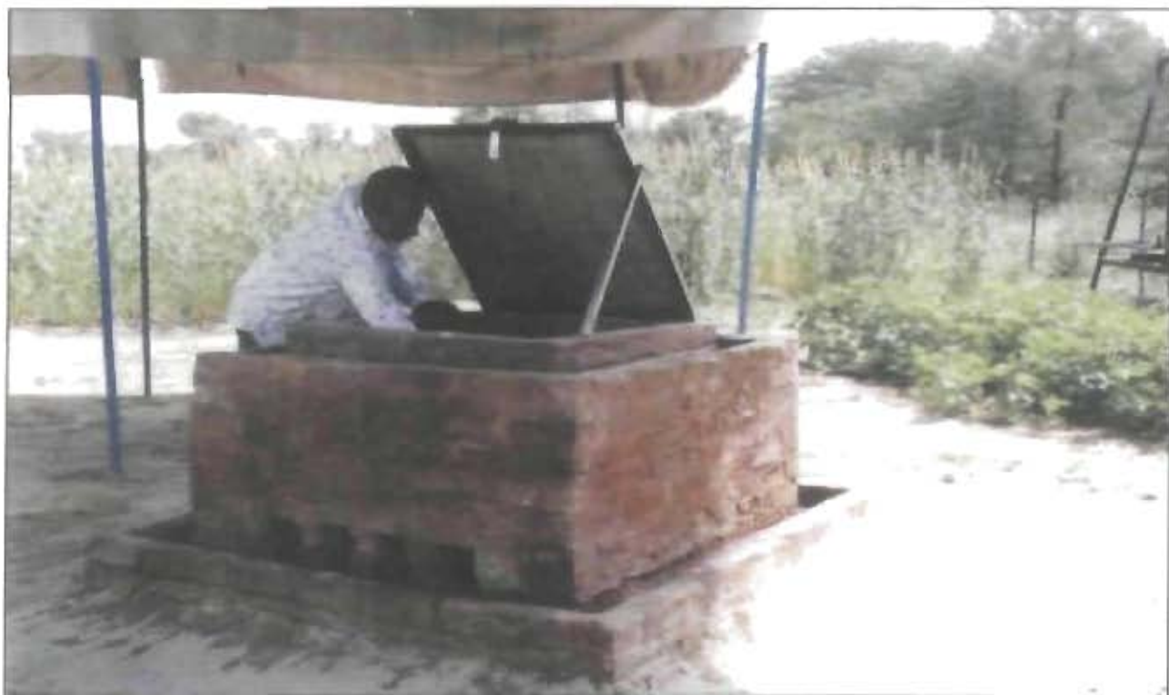
चित्र 34.3. पानी के वाष्पीकरण द्वारा शीतलता के सिद्धान्त पर आधारित कूल चैम्बर
