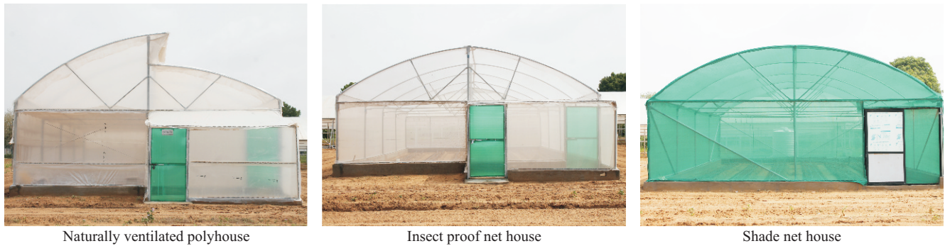
चित्र 4.3 खीरा की खेती के लिए संरक्षित संरचनाएं Fig. 4.3 Protected structures for cucumber production
